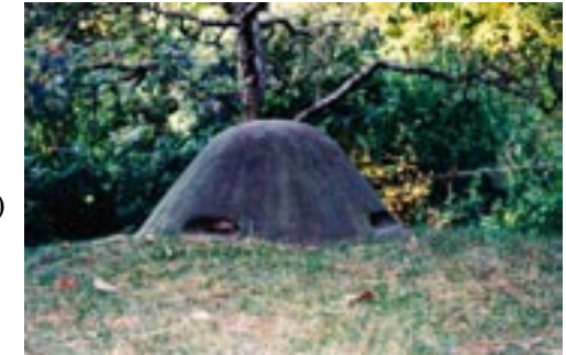
Kleinstglocke 9 P7: Außenansicht
