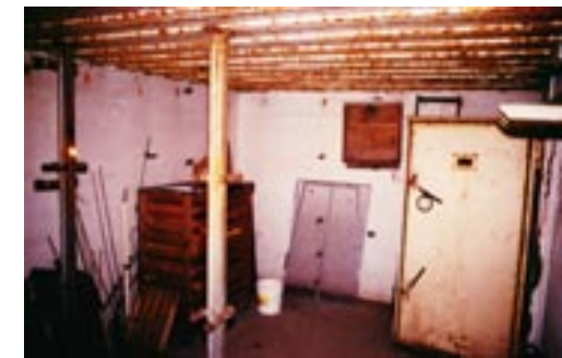
Bereitschaftsraum mit Gasschutztür 19 P7 am rechten Bildrand
